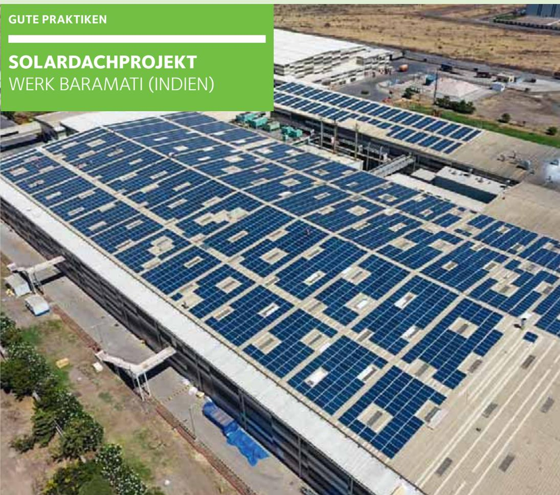
Ferrero Indien hat die Installation einer Dachsolaranlage im Werk Baramati im März 2017 abgeschlossen. Die Leistung beträgt 1,5 MW und ist damit eine der leistungsstärksten im Bundesstaat Maharashtra.
