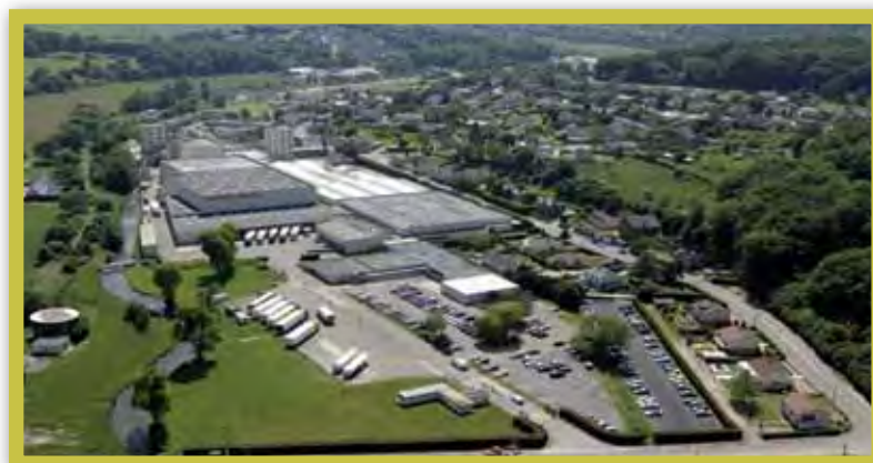
Stabilimento di Villers-Ecalles
