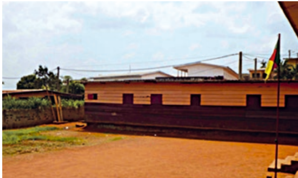
Impresa Sociale Ferrero in Camerun. Scuola Materna Cité Verte: attuale edificio in legno
